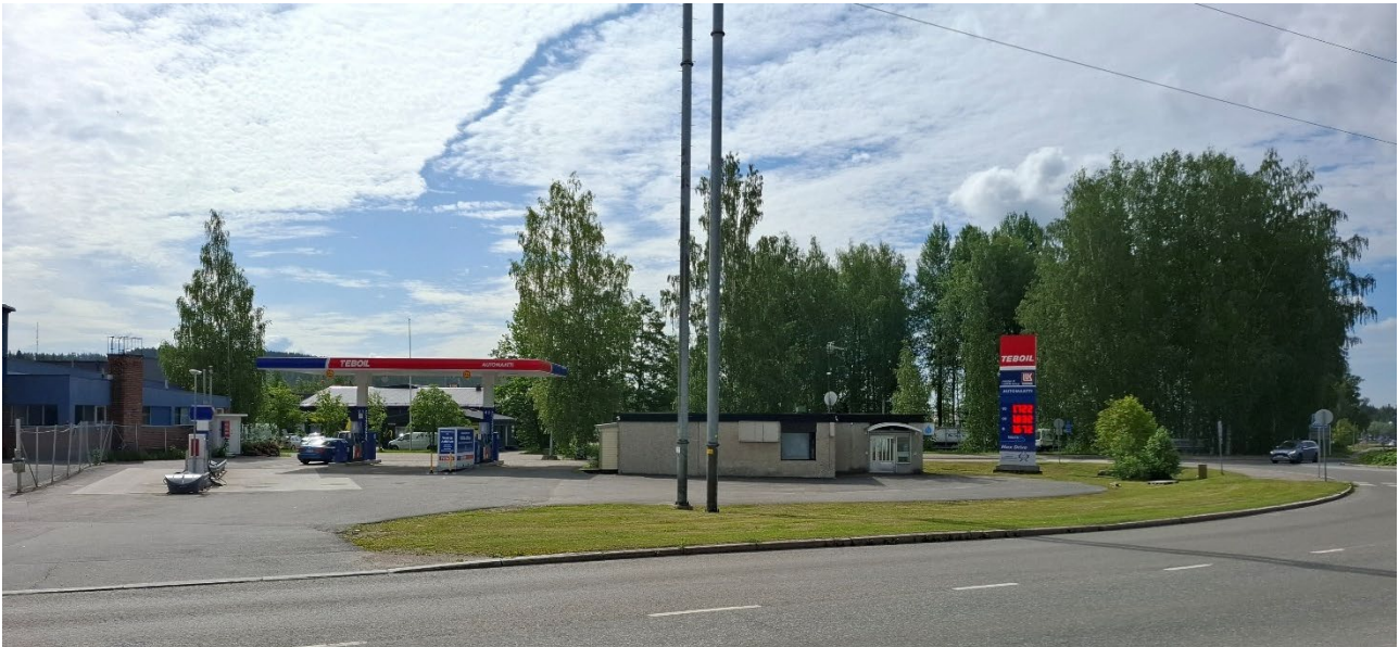
Miilukatu 1 sijaitsee polttoaineenjakeusasema ja pieni toimistorakennus.
