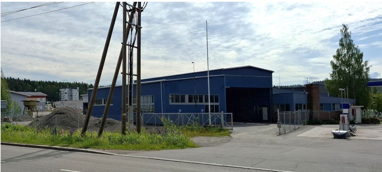
Miilukatu 3 sijaitsee väriykseltään sininen varastorakennus, johon liittyy suuri läpiajettava katosrakennelma.
